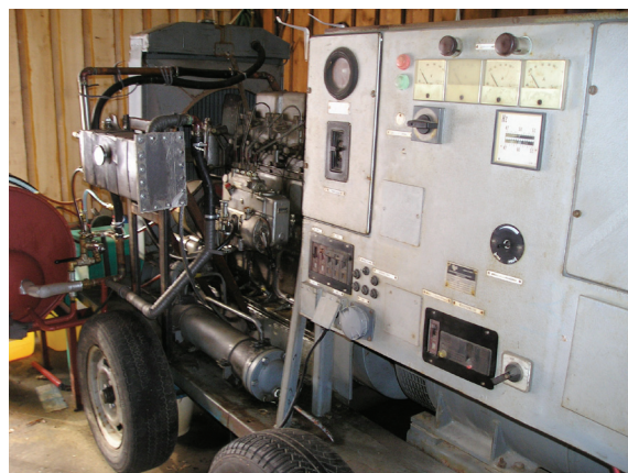
Generator zasilany olejem roślinnym
